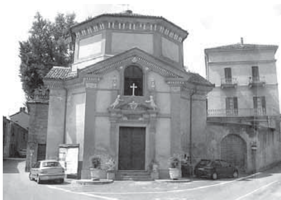
La chiesa di San Grato e scorcio di Palazzo Arborio di Gattinara oggetto di ristrutturazione
